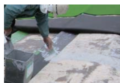
5. 下地に合った接着剤を使用して人工芝を貼り付けます。
