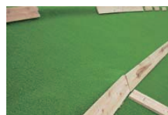
6. 段差や境目がずれないように木板や釘で仮固定します。
