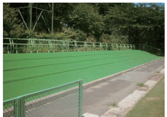
7. 接着された事が確認出来たら、最後に木板や釘を取り除いて敷き替えの完了となります。
