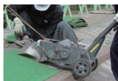
2. 剥がし機等を使用して、古い人工芝を剥がします。
